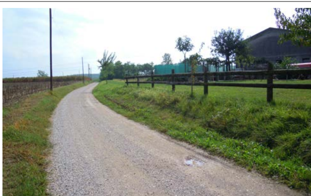
Foto n.10 - strada Casali Cisterna
